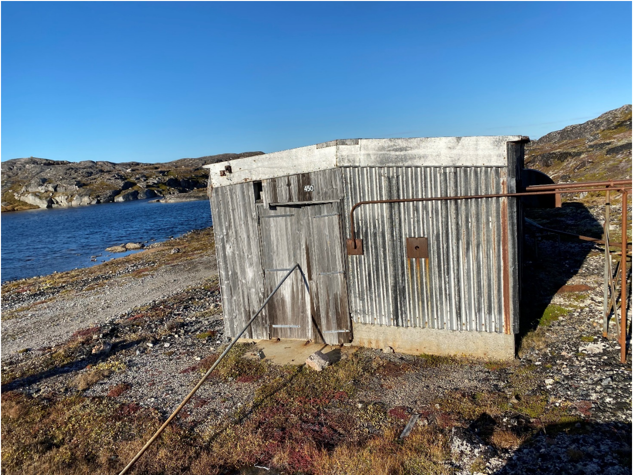
Fig. 12. B450 Skuret fungerede som pumpestation og husede nødgeneratoren. Vandreservoiret ses til venstre. Foto: Harmsen 2020, vest.
