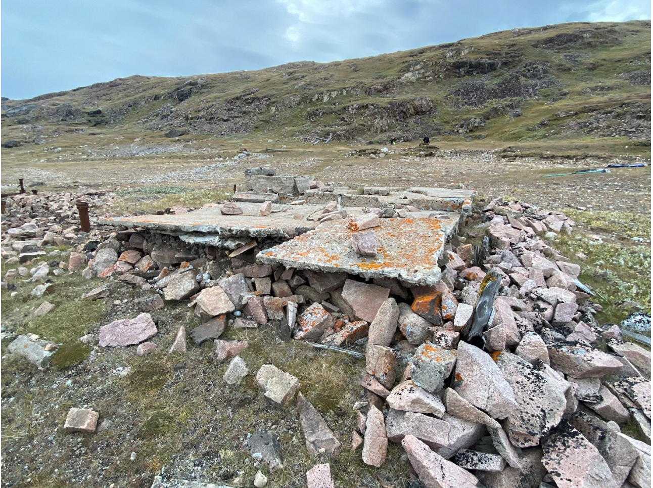
Fig. 83. F002 på Artillery Point. Betonplatformen hviler på et fundament af sten og jord. Foto: Harmsen 2020, sydvestlig retning.
