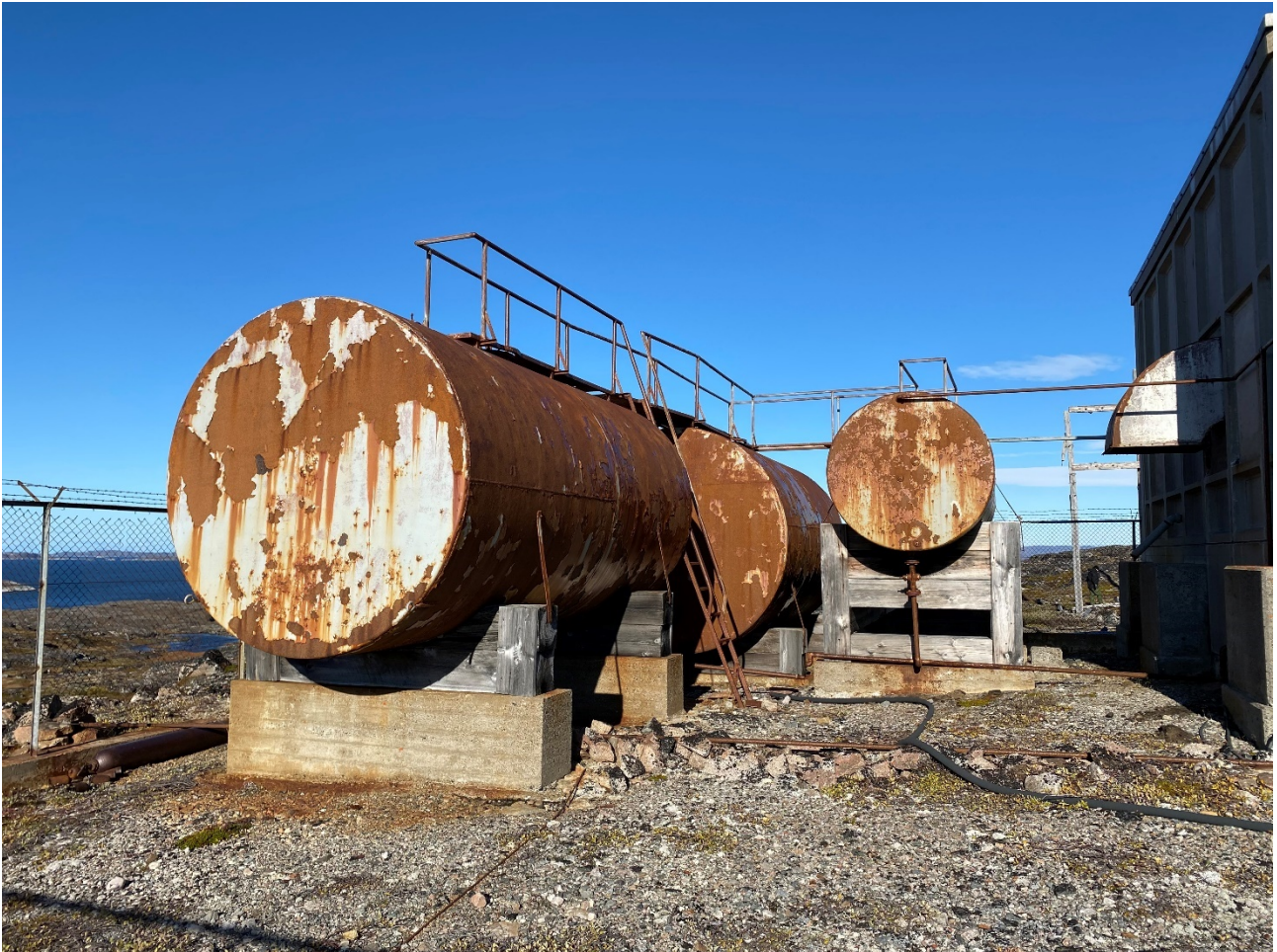
Fig. 17. Tre store olietanke fundet på sydsiden af B452. Harmsen 2020, vestlig retning.
