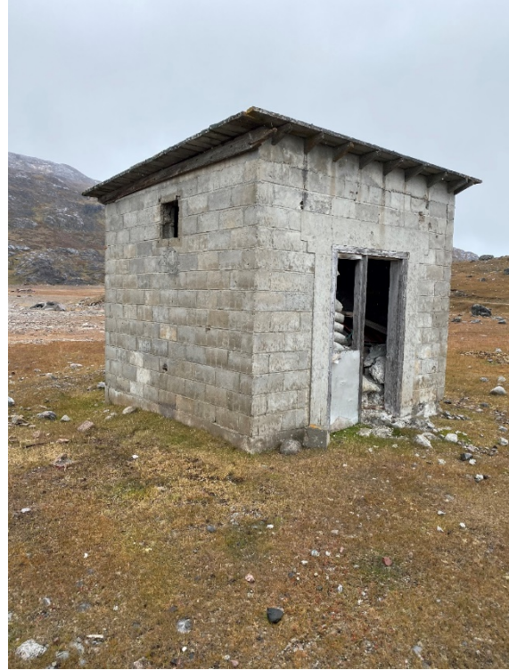
Fig. 100. Bygning B004, nordvestlig retning. Harmsen, 2020
