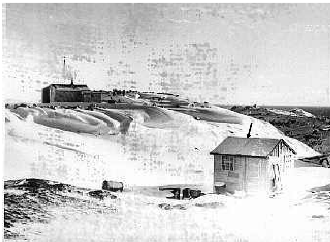
Fig. 29. Pilen, peger ned mod VHF/UHF radiosender/modtager-skuret (F010), mod sydøst. NDF - Radiosender boliger (forløber til B452?) ses på bakken i det fjerne. Foto: Jim Chase, dato ukendt. Kilde: https://www.creativehwy.net/jcstott/chase/bw3rcn.html .
