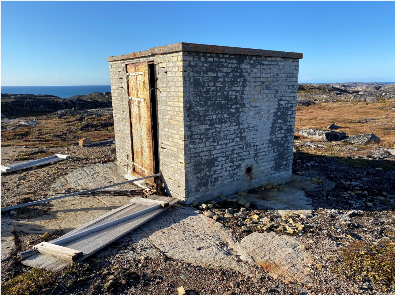
Fig. 14. B451, antenneadapterhus. Foto: Harmsen 2020, sydøstlig retning.
