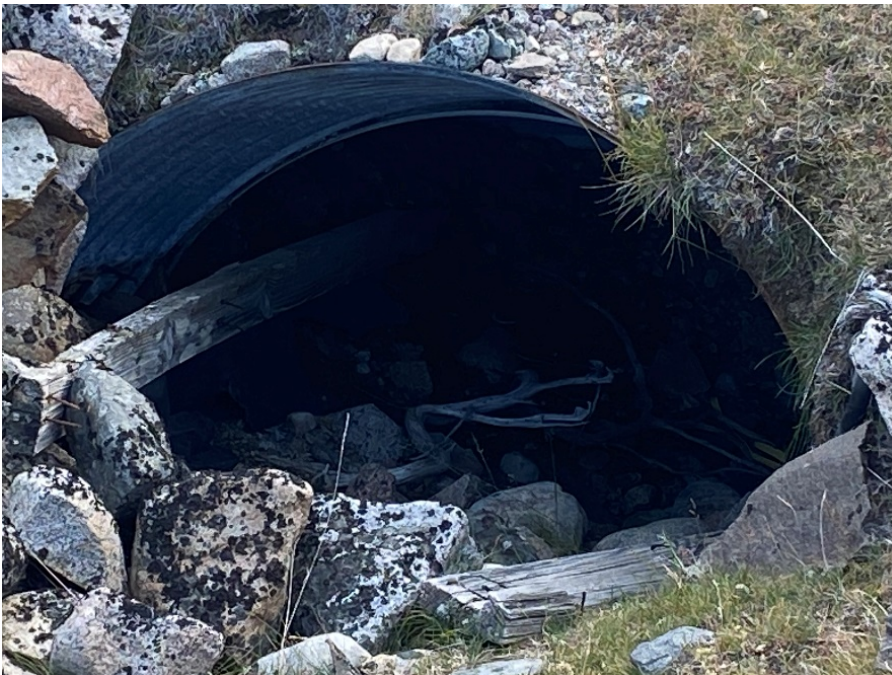
Fig. 74. Indgang til D007. Taget ved indgangen bliver understøttet med en konkav, bølget stålplade. Flere stykker skrot, træ og affald var synligt ved indgangen. Foto: Harmsen, 2020.
