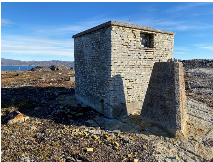
Fig. 15. B451, det tidligere NDB-antenneadapterhus sammen med en støbt beton-pylon der fungerede som mastanker (fundament F008). Foto: Harmsen 2020, nordvestlig retning.
