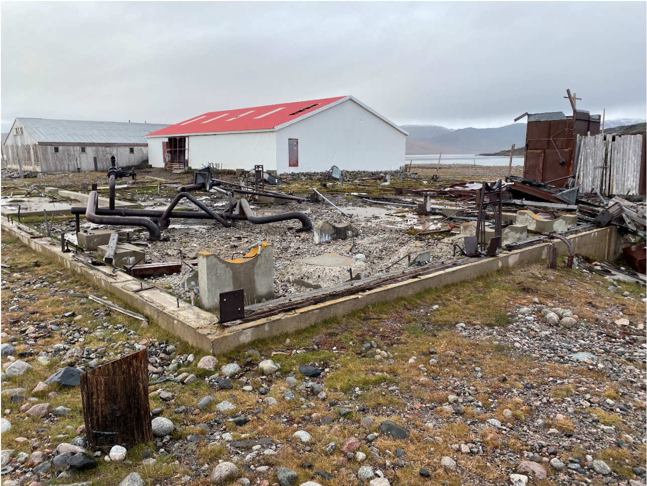
Fig. 96. To stående bygninger ses på billedet: Til venstre, B005, fårestald ejet af den lokale landmand, Eskild Paviassen. Til højre ses en mindre skur/opbevaringsbygning placeret på fundamentet af S817 (se fig. Fig. 104., anlæg nr. F012). Skuret er bygget af skrot og genbrugsmaterialer der var tilovers fra den amerikanske periode. Begge konstruktioner er bygget ovenpå fundamentet af tidligere amerikanske bygninger. Da de er opført i nyere tid, har de ingen historisk interesse.
