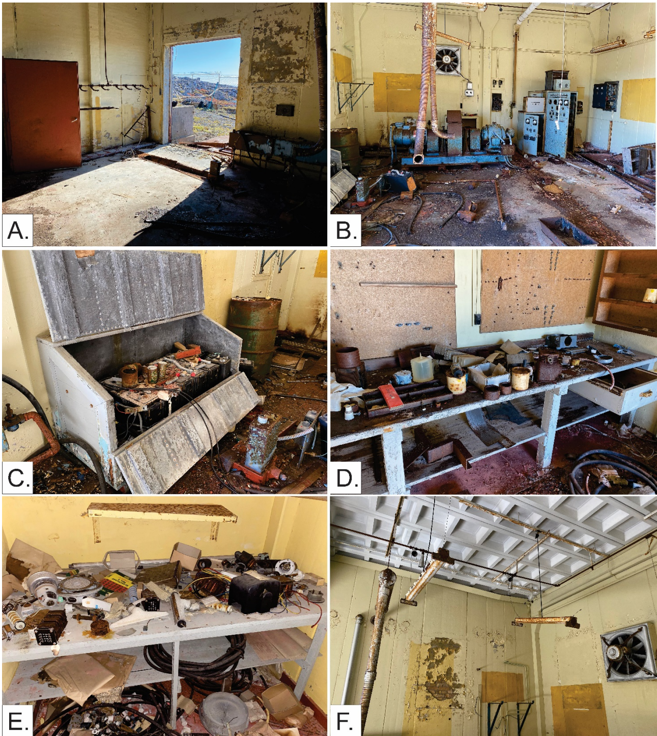
Fig. 18. Indvendige fotos af B452. (A.) Døren er faldet ud ved B452 og efterlader det indvendige hovedrum åbent og udsat. (B.) En elektrisk generator og AC regulator fundet mod den sydlige væg af hovedrummet. (C.) Tomme øldåser, malerbøtter og andet affald findes i hovedrummet. (D.) Værkstedsbord i hovedrummet. (E.) Bord fundet i opbevaringsrum med forskelligt kasseret affald og elektronik dele. (F.) Loft i hovedrummet med rør, ventilator og lamper. Alle fotos: Harmsen 2020.
