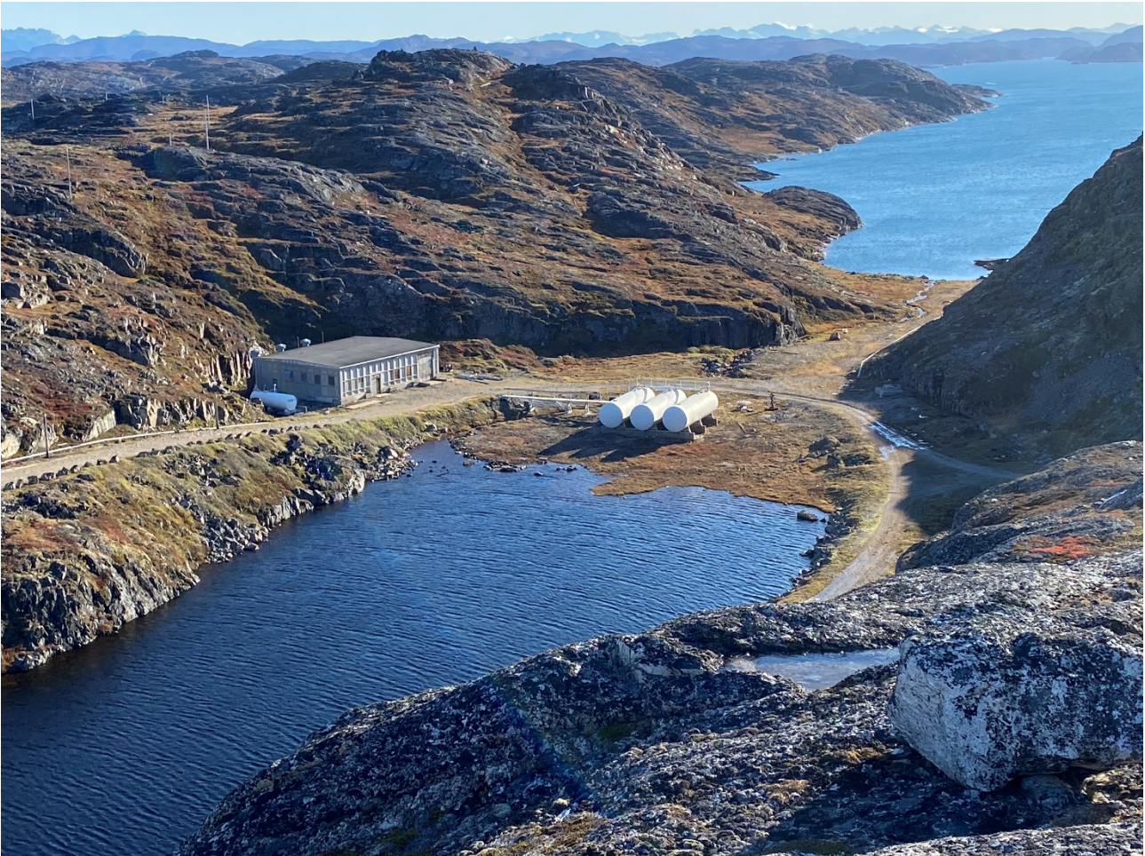
Fig. 10. B446, kraftværk og maskinværksted. Bygningen er fortsat i brug i dag. Foto: Harmsen 2020, østlig retning.
