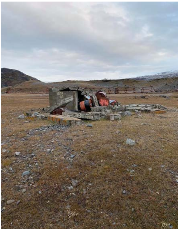
Fig. 103. Anlæg F006, tidligere S-818 helix-spolehus. Foto: Kristensen, 2020.
