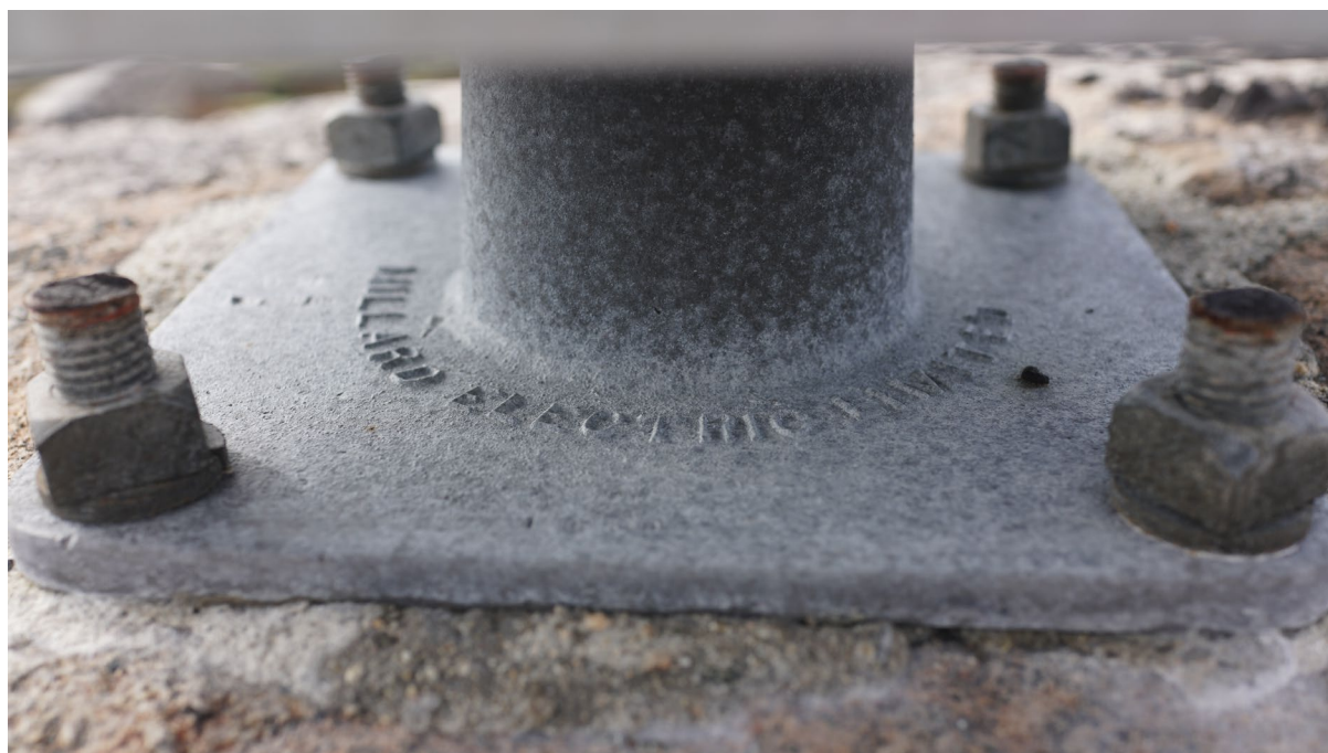
Figur 29. Fundament til en af aluminiumsantennemasterne. Fabrikat: Millard Electric Limited.
