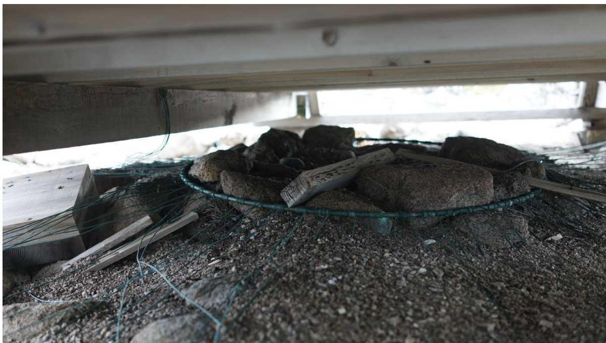
Figur 28. Under NDB-bygningen ligger den del af antenneanlægget som består af kobberwires der "stråler" ud i en radius på omkring 50 m.
