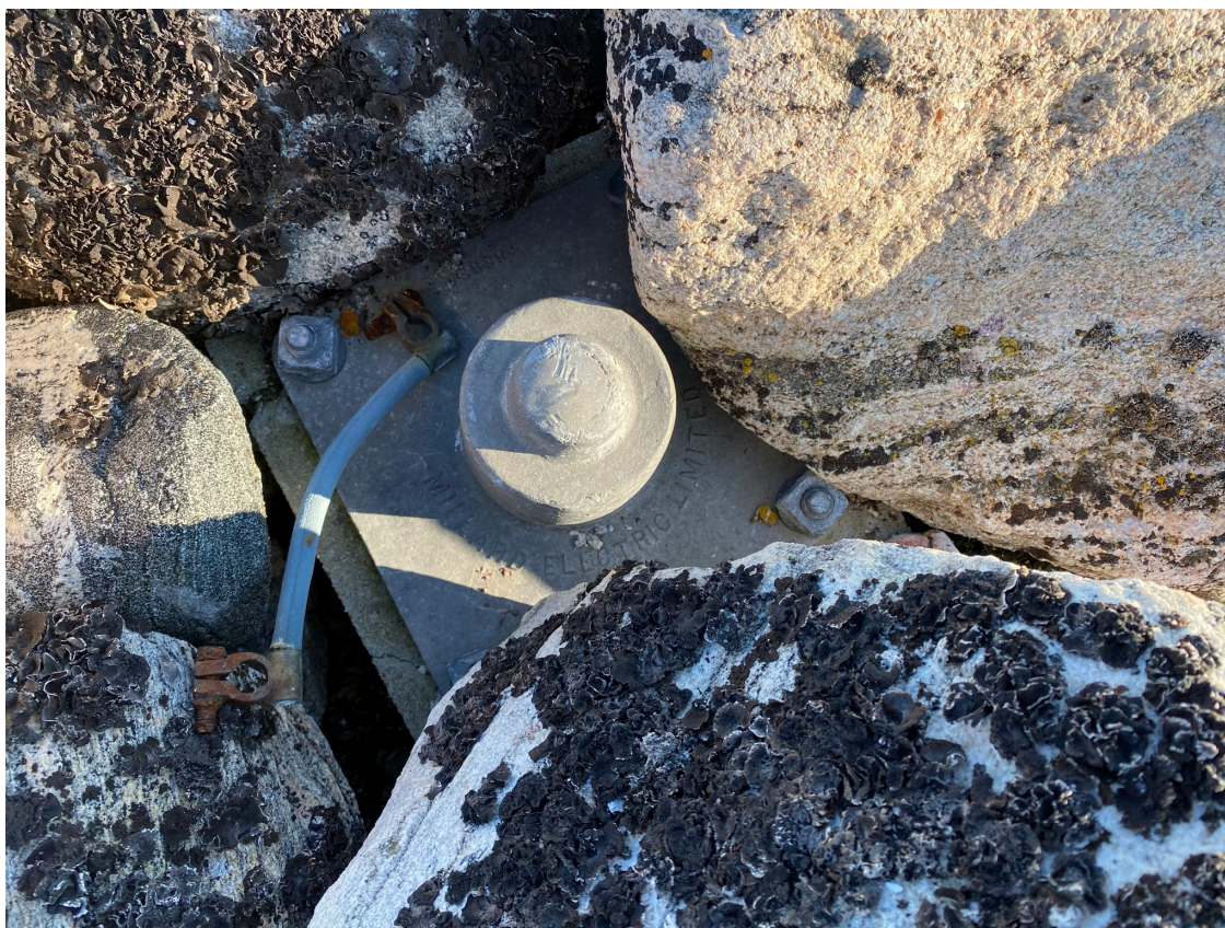
Figur 8. Mastefundament fabrikeret af Millard Electric Limited. (Foto: M. Myrup)
