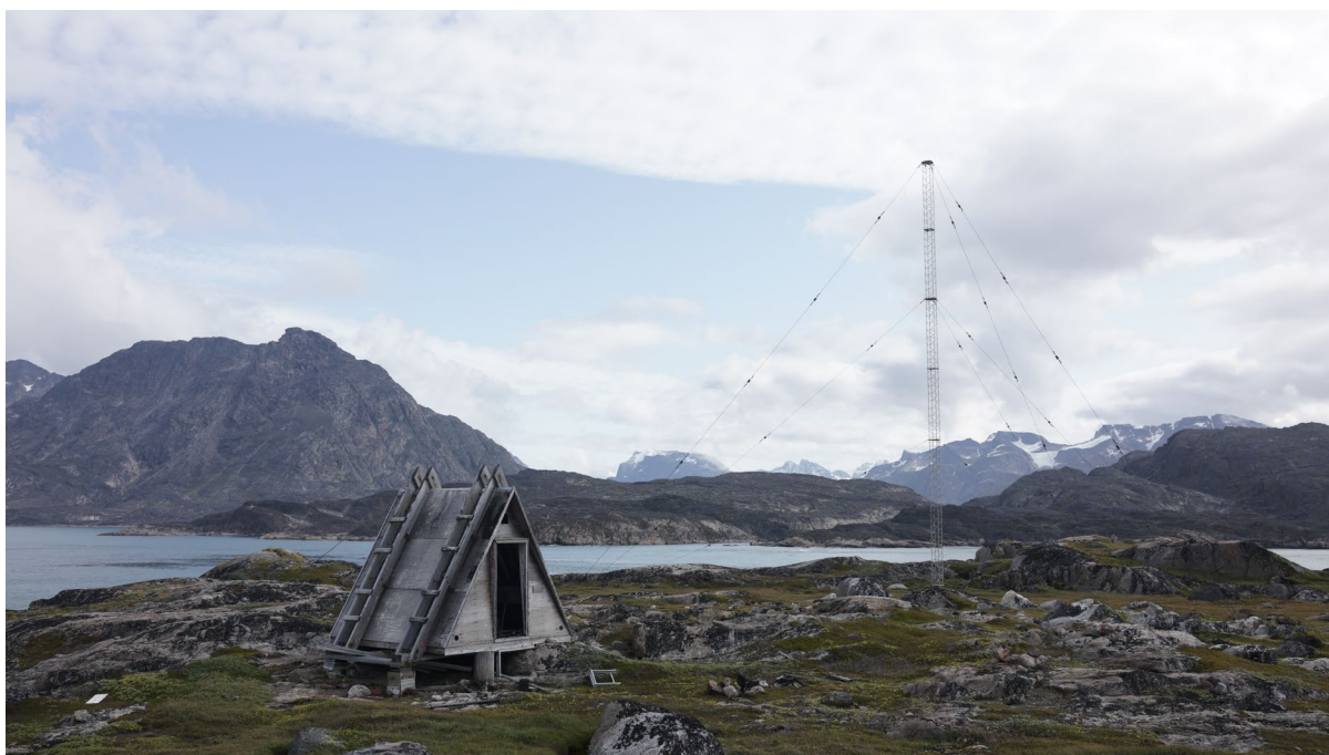
Figur 27. NDB-bygningen med en af antennemasterne i baggrunden set fra NNV. (Foto: M. Myrup)
