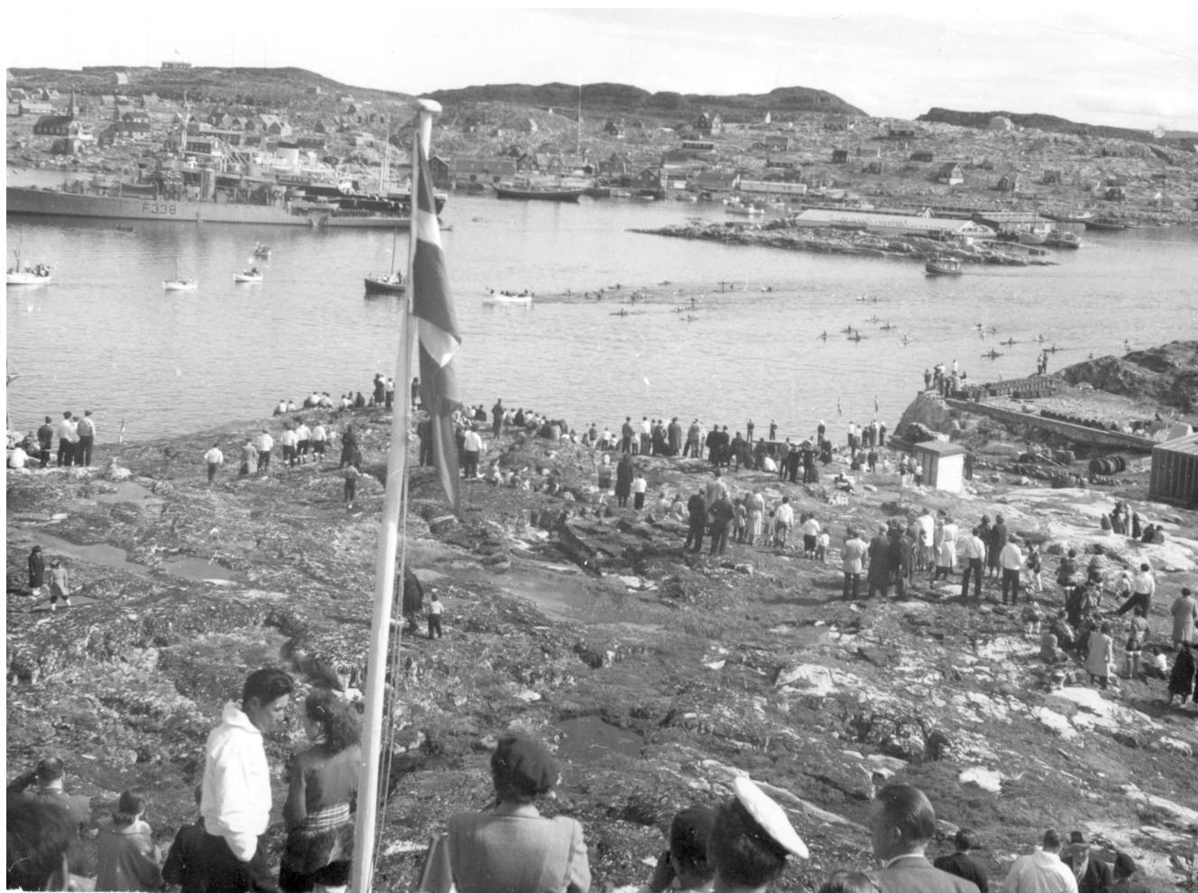
Figur 14. Kongebesøget i 1952 er her forevigeet. På fotoet ses en del tromler liggende på kajlæggget. Det nyere betonfundament med skinneanlæg er ikke opført endnu. På fundamentet hvor BW5-barakken står, er opført et bygningsværk som dog ikke findes længere. Dens omrids kan dog anes på fundamentfladen den dag i dag. (Foto: NKA)
