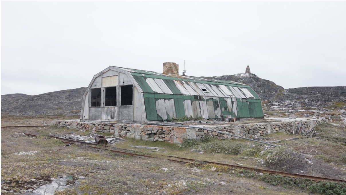
Figur 19. BW5's mandskabsbarak opbygget i hovedsaligt krydsfinér. I forgrunden ses det efter 1952 etablerede skinneresystem. I baggrunden troner kongevarden på en klippe. Fundamentet barakken er opført på blev bygget i 1905-05. (Foto: M. Myrup)
