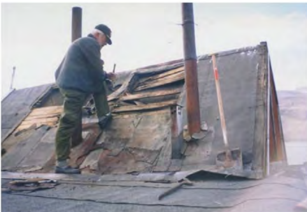
Jannik er i gang med at reparere taget af Hoelsbu Feltrapport 1999
