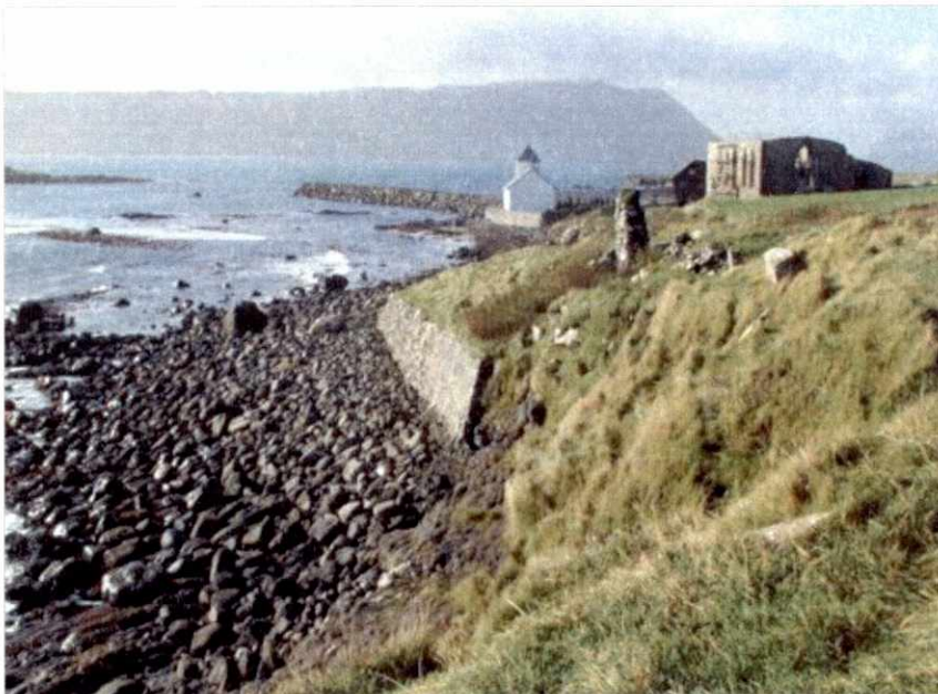
Figur12. Eksempel fra Kirkjubøur på Færøerne, hvor man har forsøgt at sikre kirkeruinen ved at opføre et massivt skråningsværn.
