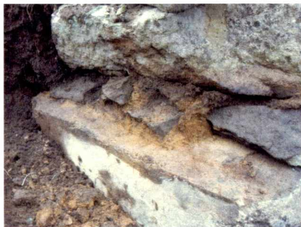
Fig. 33. Der påvistes brug af ler i murkonstruktionen
