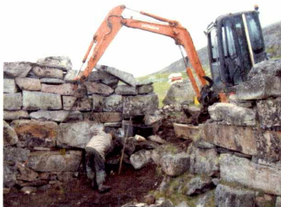
Fig. 29. Den nedfaldne sten i vestgavlen sættes på plads
