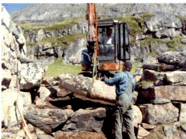
Fig. 34. Den største af de nedfaldne sten i nordmuren sættes på plads.
