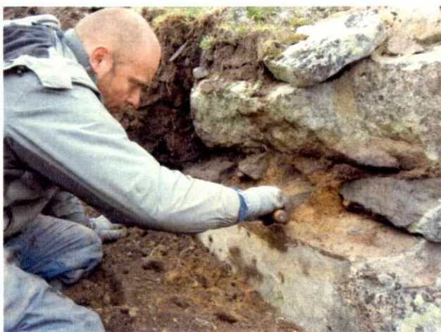
Fig. 32. Jacob renser op i nordmuren inden sten lægges på plads.
