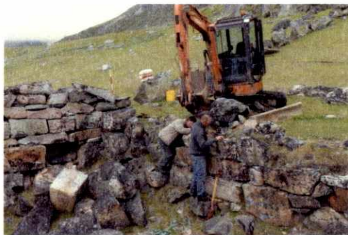
Fig. 25. Enkelte sten kunne lægges direkte på plads
