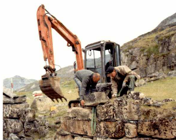
Fig. 35. Nordmuren under genopførelse.
