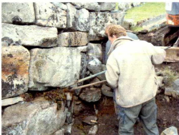
Fig. 30. Tang bruges som glidemiddel for at få den tonstunge sten i vestgavlen på plads.
