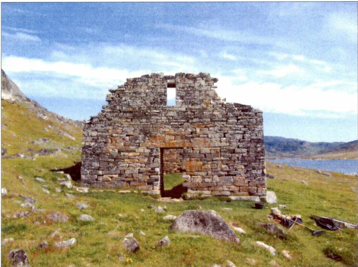
Det stabiliserede murhjørne efter arbejdets færdiggørelse set fra vest og nordvest. Øverst th. de tre indsatte sten markeret med blå kridt som ved de øvrige tilførte.
