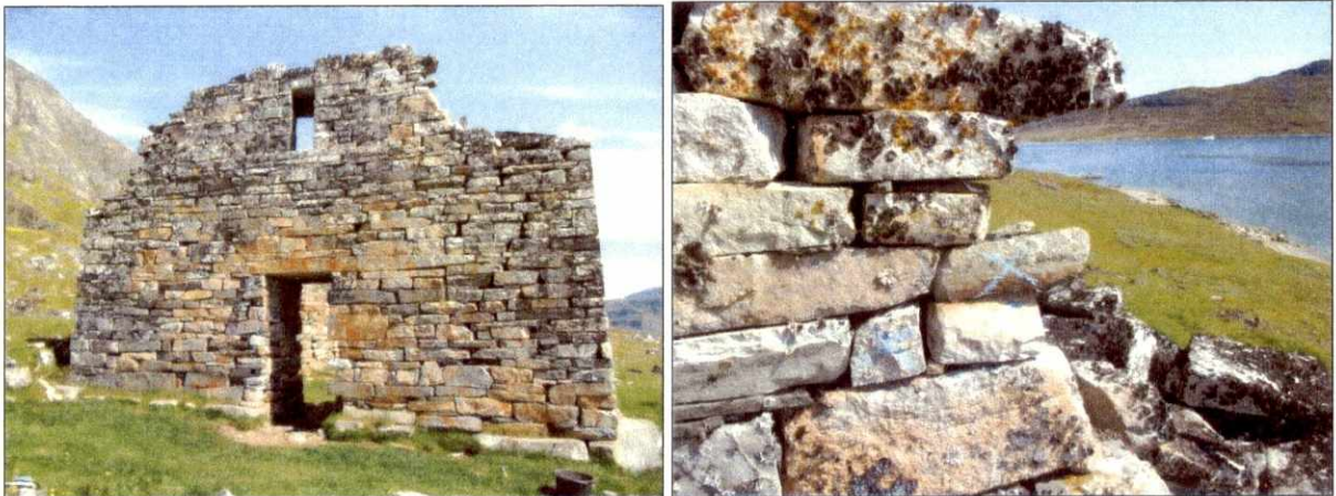
Det stabiliserede murhjørne efter arbejdets færdiggørelse set fra vest og nordvest. Øverst th. de tre indsatte sten markeret med blå kridt som ved de øvrige tilførte.
