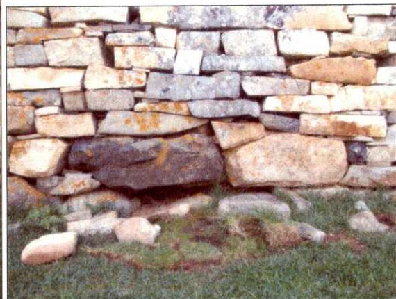
Det kritiske sted under østgavlens vinduesniche som fundet! Set fra vest.
