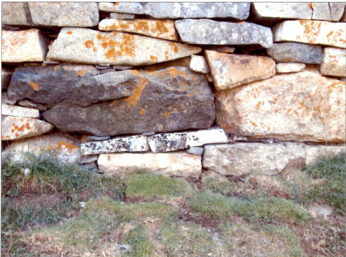
Den originale underliggende sten funderes ordentligt og oprettes - og to passende lyse sten indsættes for at stabilisere murværket på dette vigtige sted.
