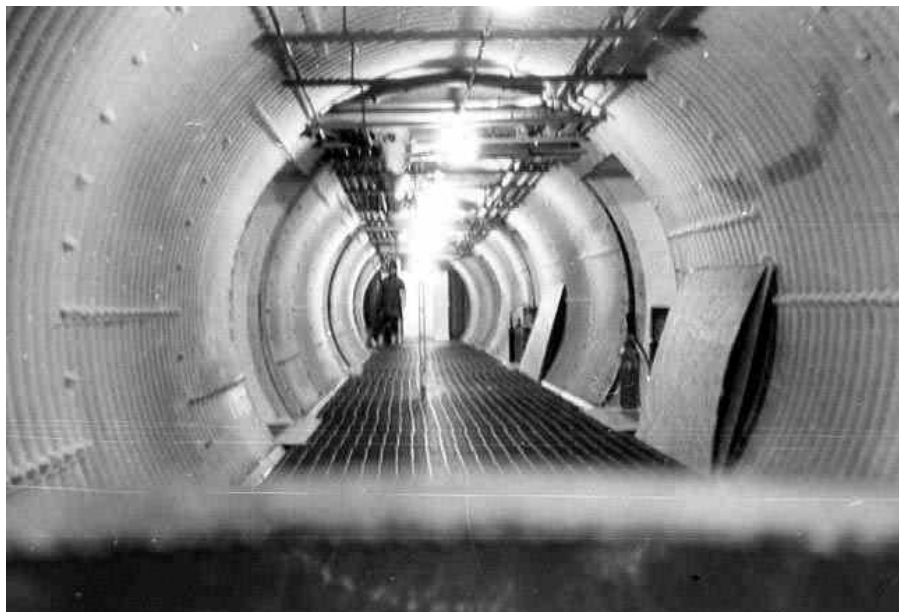
Uopvarmet forbindelsestunnel mellem forskellige afdelinger. Foto: Joe Baude, http://www.radomes.org/museum/
