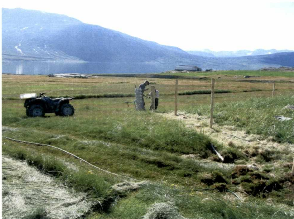
Fig. 13. Trådnets strammes op med et spil
