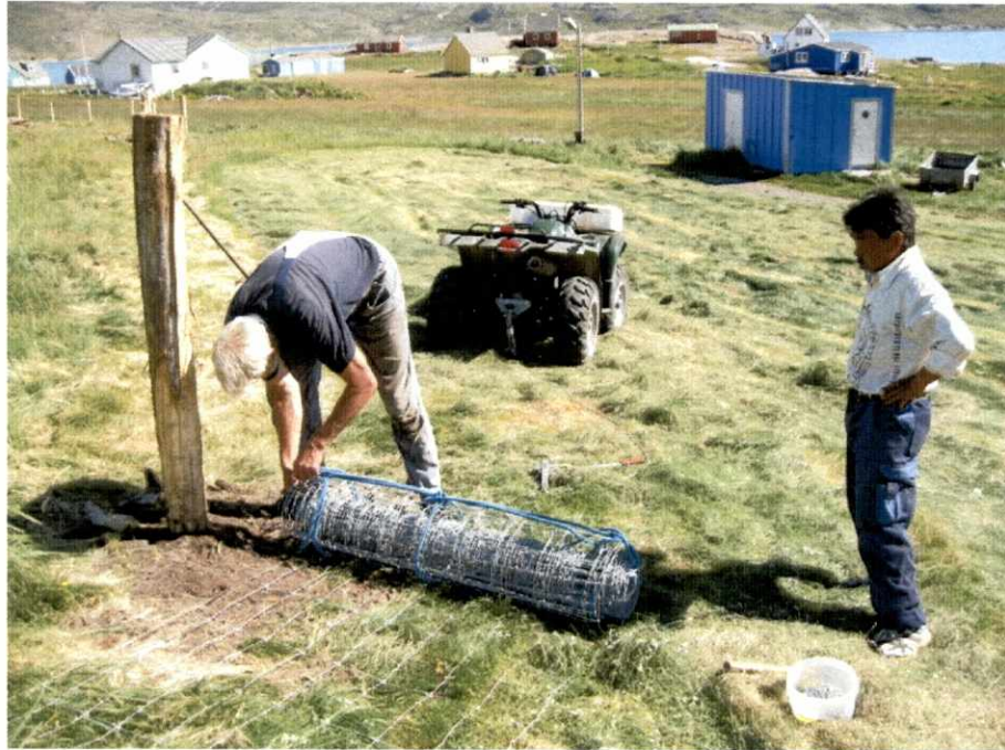
Fig. 12. En trådnetrulle bindes op og forbindes til et spil der er forbundet til den firehjulede motorcykel
