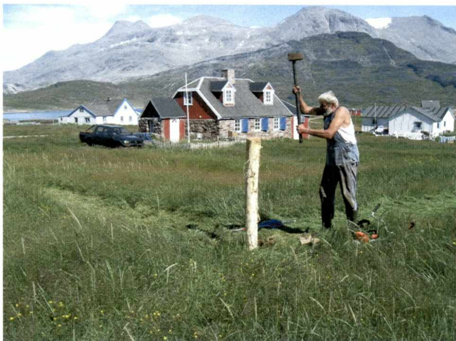
Fig. 11. En af de kraftige pæle slås ned det sidste stykke med en forhammer. Set fra SV.
