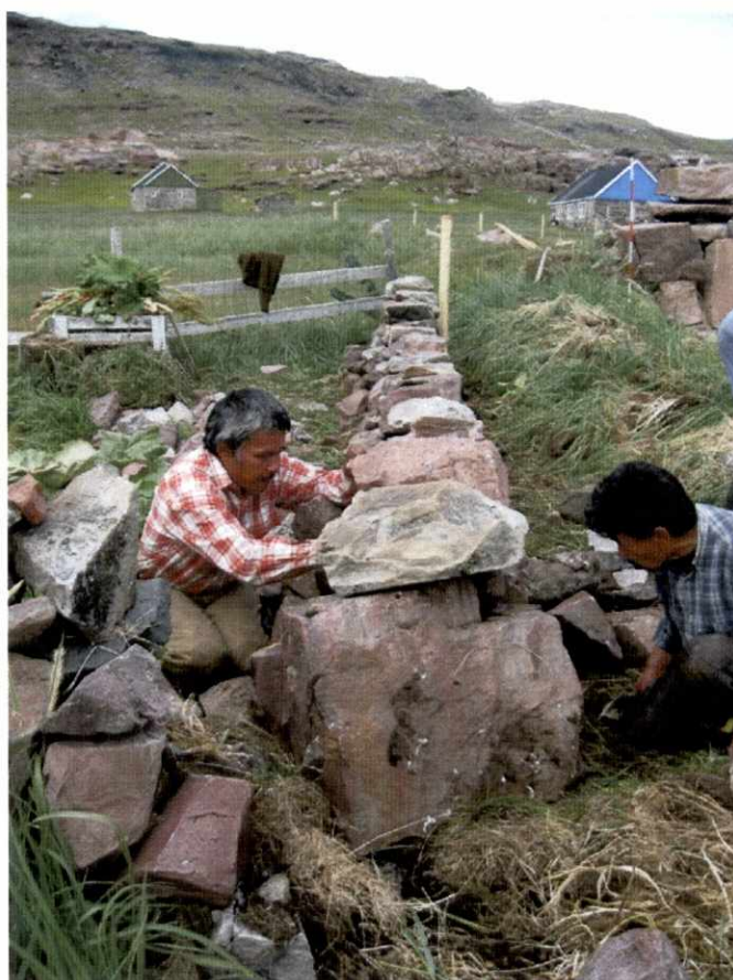
Fig. 5. Opbygning af nyt stengærde i have C. Set fra ØSØ.
