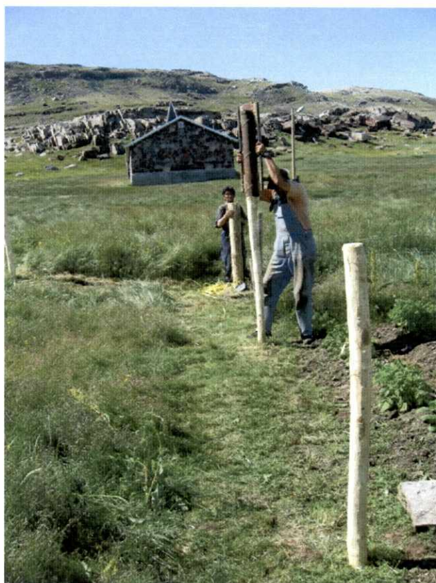
Fig. 10. Pæle slås i med en rørhammer. Set fra øst.
