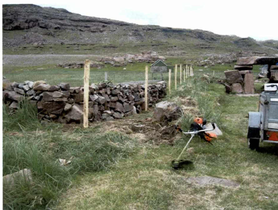
Fig. 7. Nedhamrede pæle mellem have C og den store kostalds sydlige langside. Set fra øst.
