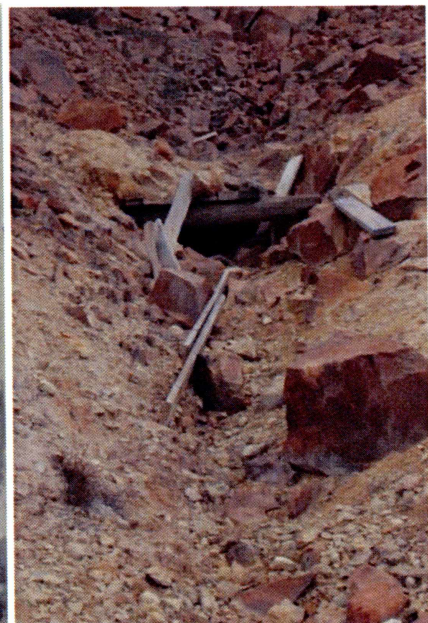
Fig. 46. Den sammenstyrtede indgang til minen 2008
