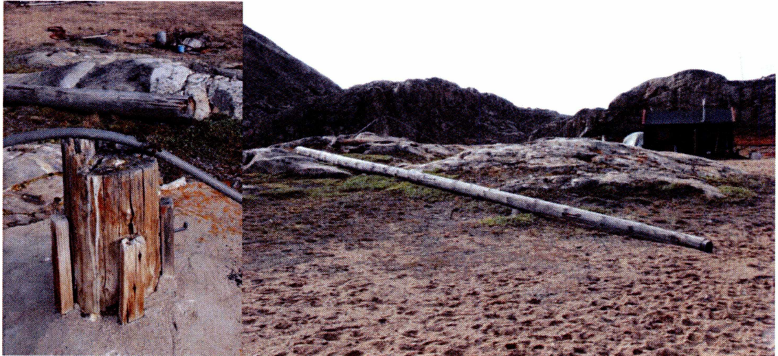
Fig 37. Tv: 'Stub' fra radiomast stående i betonfundament. Den bøjede jernstang er yngre tilføjelse. Th: den væltede radiomast liggende foran klippe med 'stub'.
